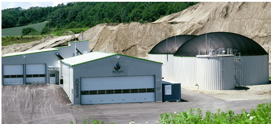
Figura 3: Planta de biogás
