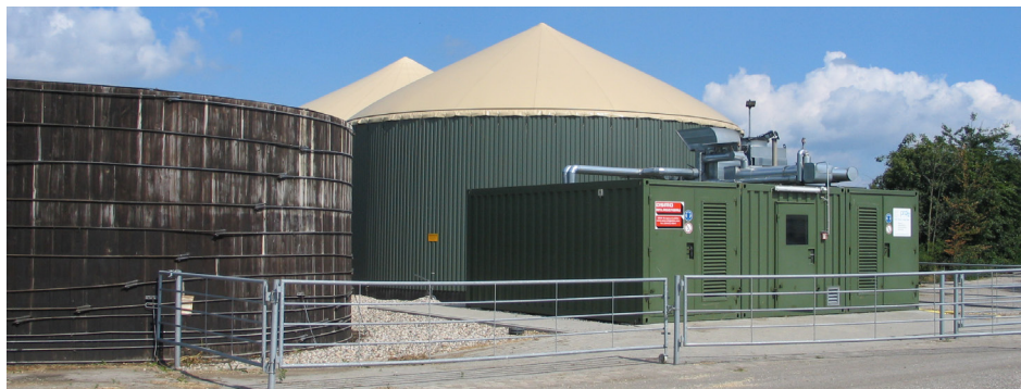
Figura 9: Planta de biogás
