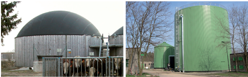
Figura 19: Ejemplos de reactores de mezcla completa
