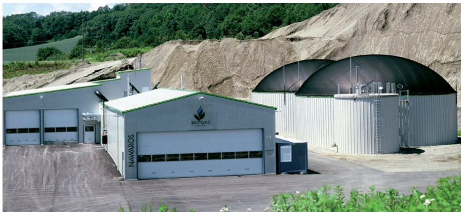
Figura 3: Planta de biogás
