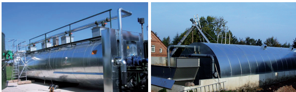
Figura 20: Ejemplos de reactores de flujo pistón
