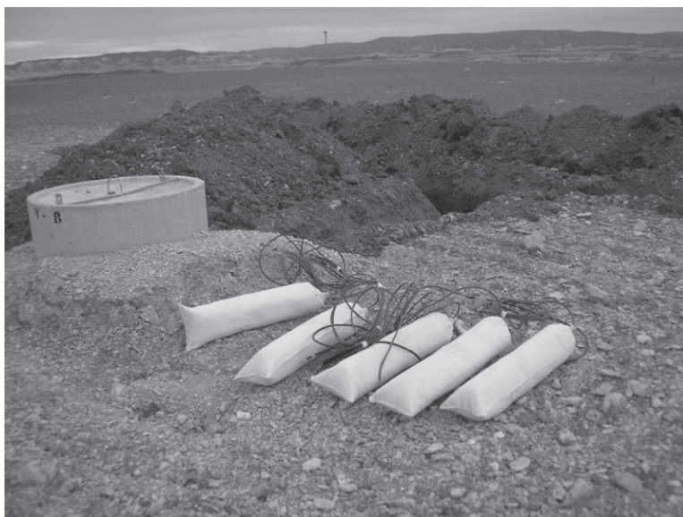
Figura 6.29. Ánodos de sacrificio preparados para su instalación.
