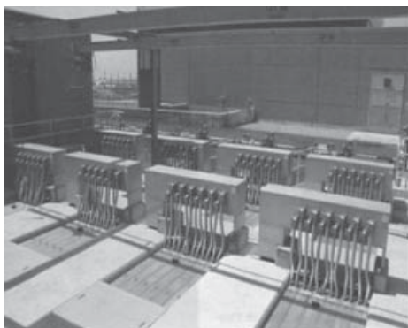
Ultravioletas ITT Wedeco en EDAR Baix Llobregat
