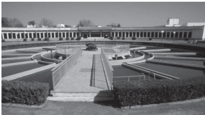
Figura 1.11. Decantador Accelerator ETAP-EMACSA (Córdoba).
