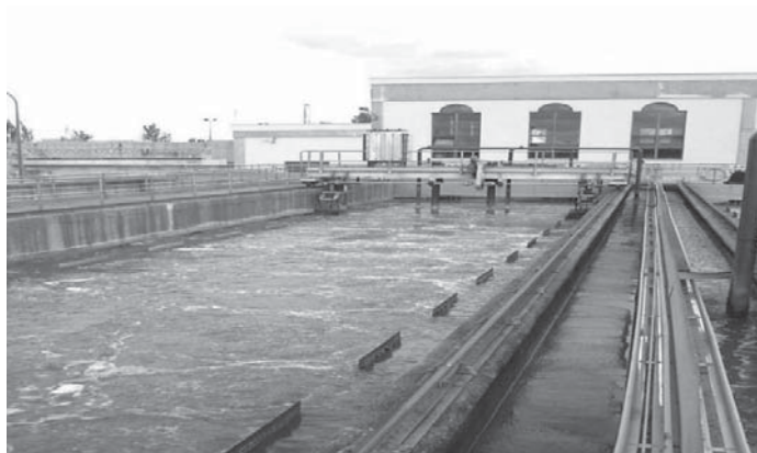
Figura 2.4. Desarenado-desengrasado de la EDAR de La Golondrina-EMACSA (Córdoba).
