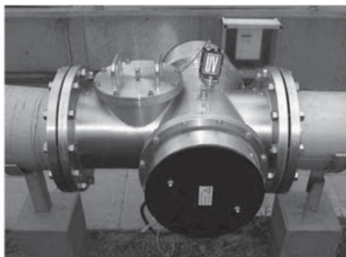
Figura 1.27. Oxidación mediante radiación UV: izquierda, en cámaras de oxidación; derecha, en tubería (fuentes: Infoenviro™ y TEQMA™ ).
