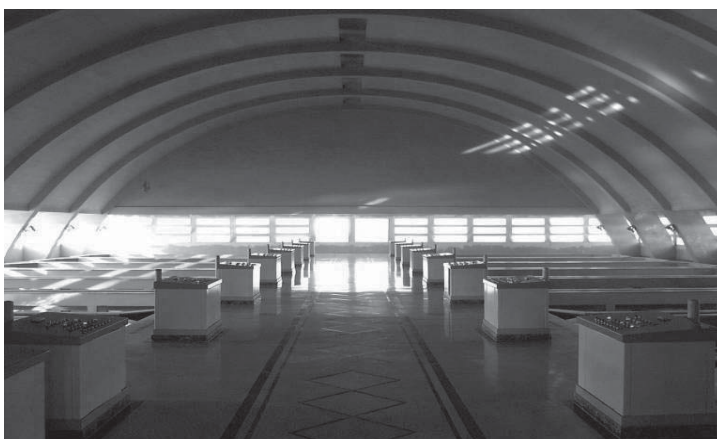
Figura 2.14. Sistema de filtros rápidos de arena de la ETAP de Villa Azul-EMACSA (Córdoba).
