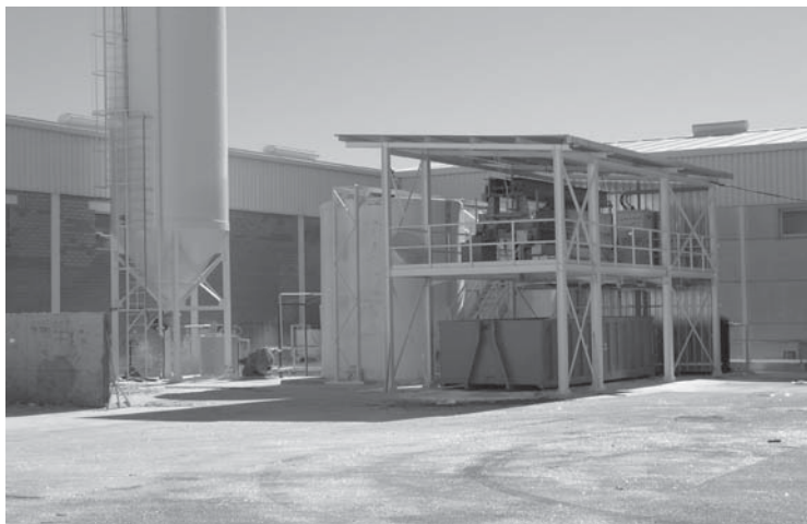
Figura 5.7. Depuración de efluentes procedentes de una vidriera.
