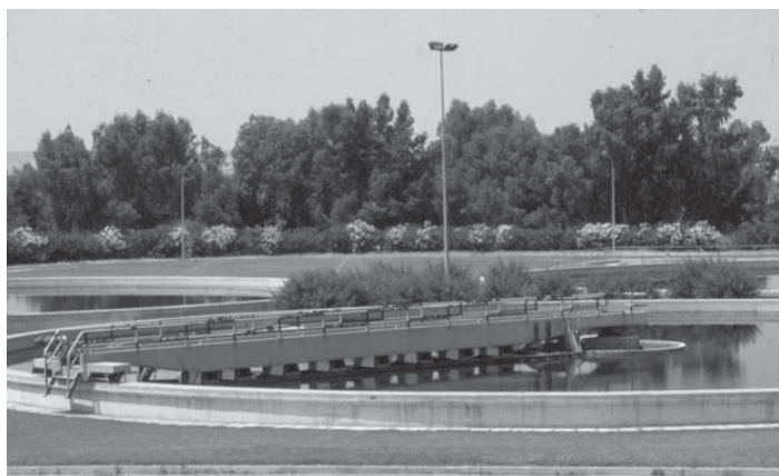
Figura.1.12. Decantador EDAR-EMACSA (Córdoba).
