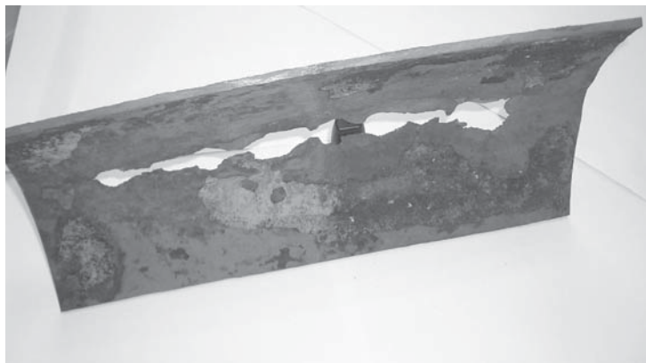
Figura 6.23. Tubería de fundición severamente corroída.
